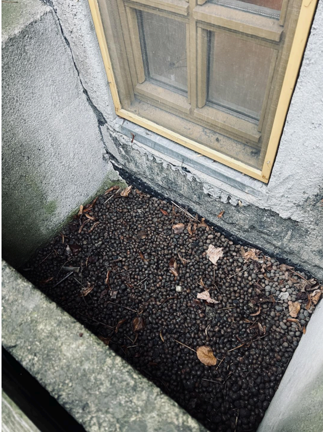
Synlig grunnmursplast på hagesiden.
