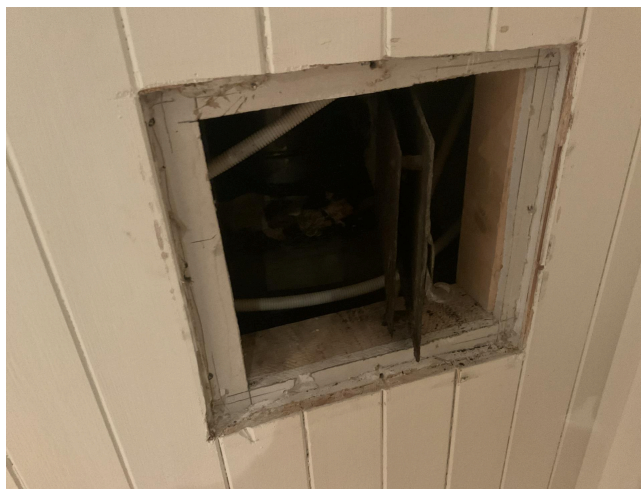
Feieluke i kjeller. Pipe/feieluke innkledd med treverk.
