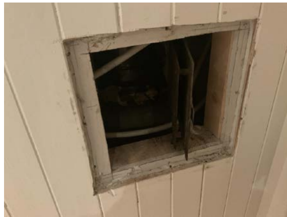
Feieluke i kjeller. Pipe/feieluke innkledd med treverk.
