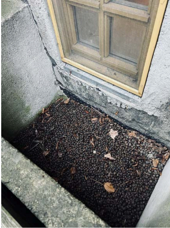
Synlig grunnmursplast på hagesiden.
