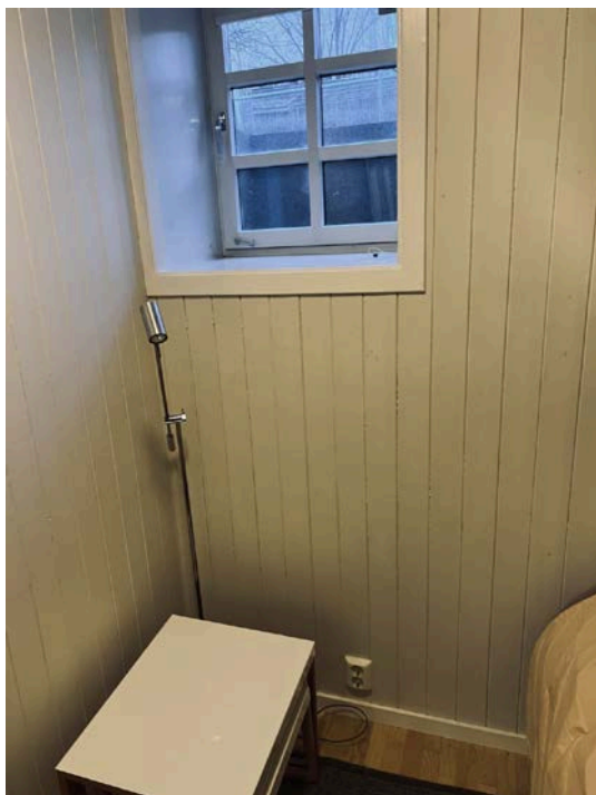
Vinduer i kjeller er plassert høyt oppe på vegg.
